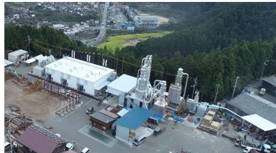
バイオマス発電所(左)とペレット工場(中央)
