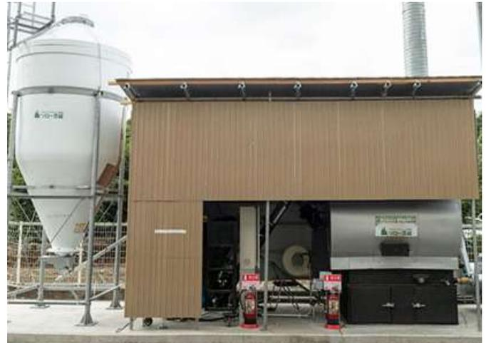
食品工場(茨城県小美玉市)などに導入されたペレットボイラーに木質ペレットを供給。灯油・重油ボイラーと比較しCO2排出の削減に貢献しています。
