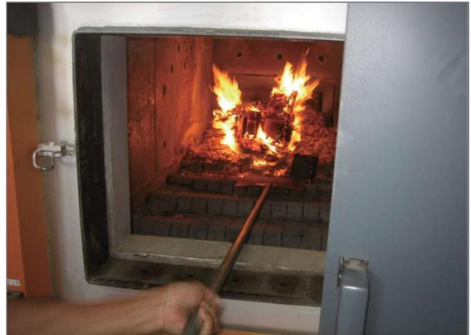
【最上町ウェルネスプラザ】木質チップ焚きボイラ550kW、700kW、900kWの3機種による地域熱供給システム（冷暖房・給湯システム。対象：病院・特別養護老人ホーム・デイサービス等）
